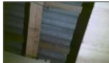
Photo N° 003 -2ème-Combles- Plafonds-Toiture ondulée (Fibres- ciment)
