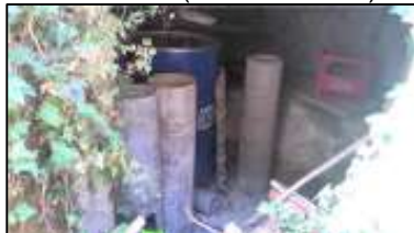
Photo N° 005 -Extérieur-Abris- Gaines et coffres-Chute (Fibres- ciment)
