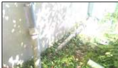
Photo N° 002 -S.sol-Cave 1 S.sol- Gaines et coffres verticaux-Gaine extérieur E.P.(Fibres-ciment) X2
