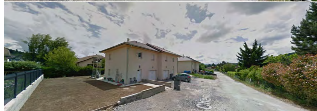
VUE DEPUIS LA ZONE DE RETOURNEMENT EN FOND D'IMPASSE
